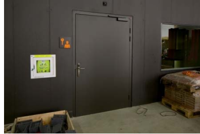
2 Halle 1.2, bei Hallenchefbüro
